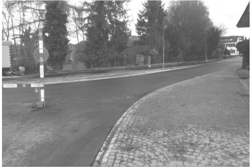
Die vorgesehenen zwei Etappen der Sanierung Kleinfeldstrasse (Strassenbau und Werkleibungsbau) konnten wie geplant vor dem Winter 2018 / 19 abgeschlossen werden. Die neue Strasse wurde mit der alten Strasse provisorisch verbunden. Somit kann die Kleinfeldstrasse bis zur Wiederaufnahme der restlichen Arbeiten (je nach Wetter ab ca. Mitte Januar 2019) frei befahren werden. Der Winterdienst ist somit garantiert.
